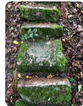
Befintligt trapplopp som förbinder Myntvägen med Dalstigen/Bruksvägen rustas. Foto: Sweco
