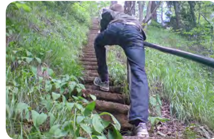
Meurells trappor är branta och utmanande. De är i stort behov av upprustning. Foto: Team Solde
